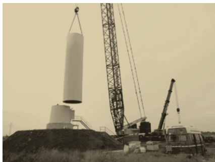
Imagen 1. Montaje de una torre de aerogenerador
